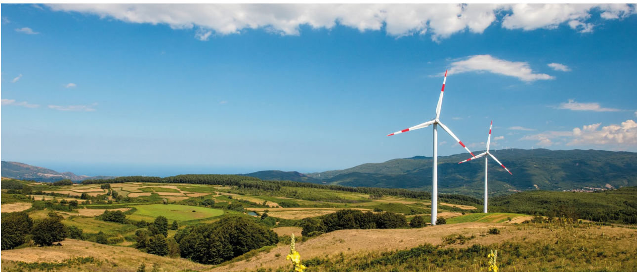
Impianto di Torre di Ruggiero - Italia
