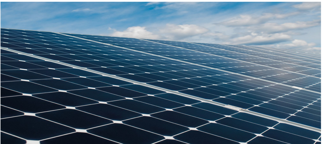
Impianto di Aubenas - Francia
