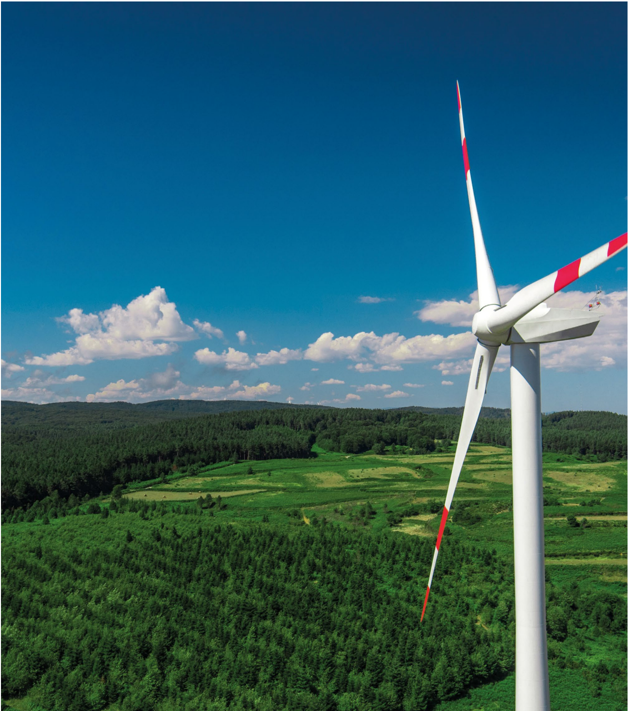
Impianto di Torre Di Ruggiero - Italia
