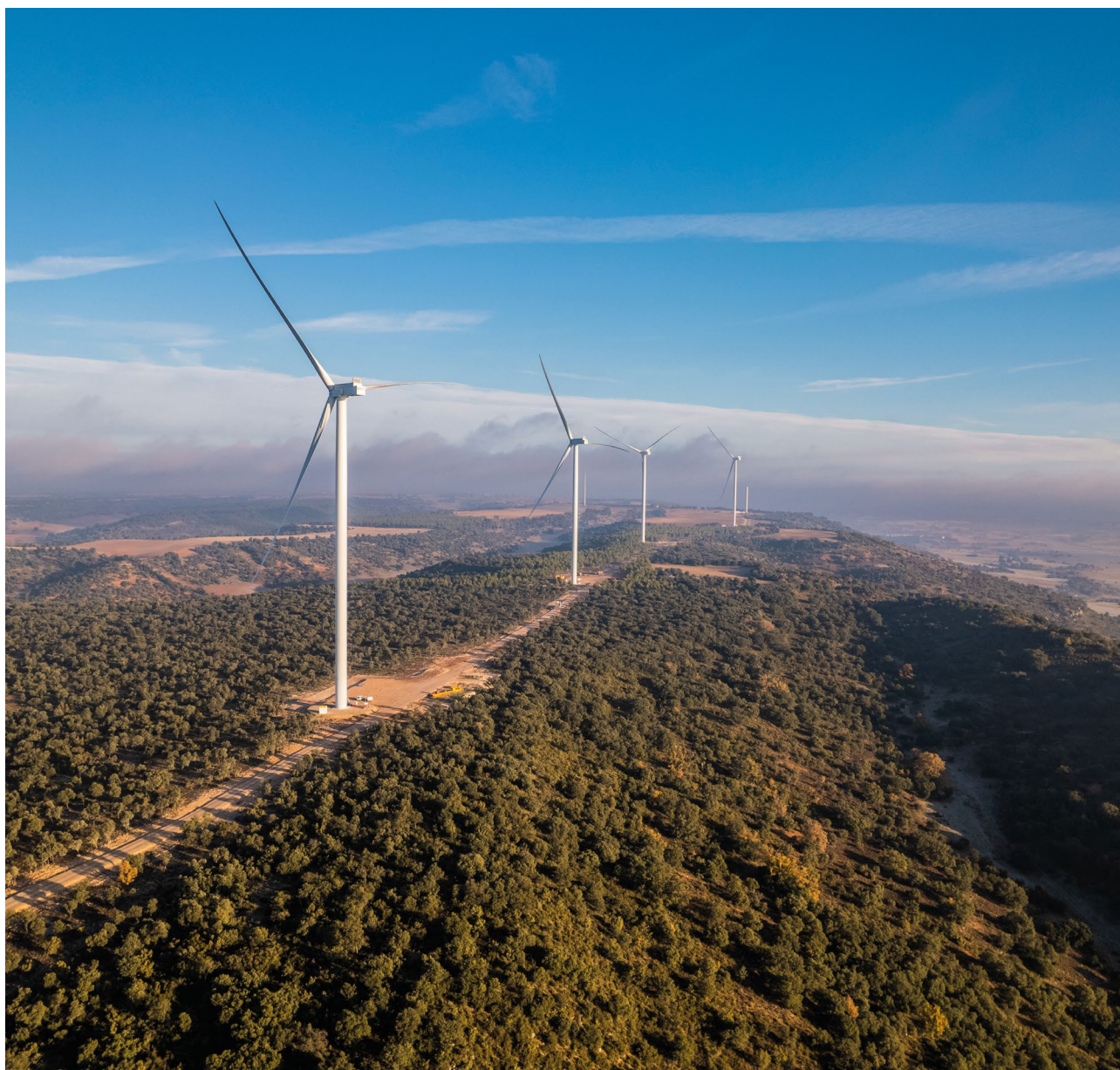
Impianto di Delmonte - Spagna
