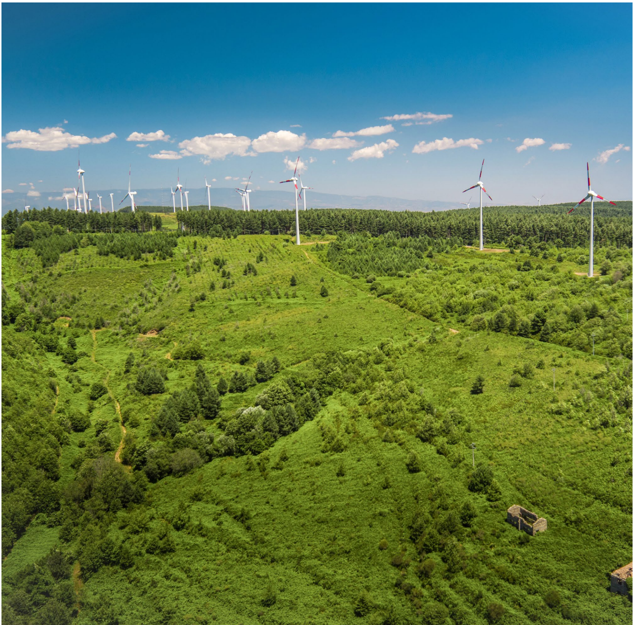
Impianto di Olivadi - Italia
